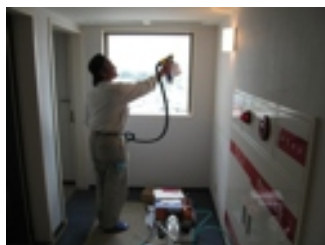
吹き付け施工中
